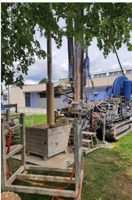
Mit Beginn der Sommerferien Ende Juli starteten die Bohrarbeiten für die geplante Grundwasserwärmepumpe der neuen Turnhalle an der Leonhard-Stadler-Straße. Dabei wurde am 8. August bei 20,50 Meter unter Geländeoberkante zunächst wie erwartet Grundwasser angetroffen, das entspricht der im Vorfeld durchgeführten geologischen Untersuchung.
